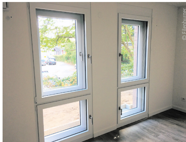
Abb. 8: Raumhohe Eilenburger Hafencity-Fenster mit zwei Flügeln und 39 dB Schalldämmwert (teilweise geöffnet)
