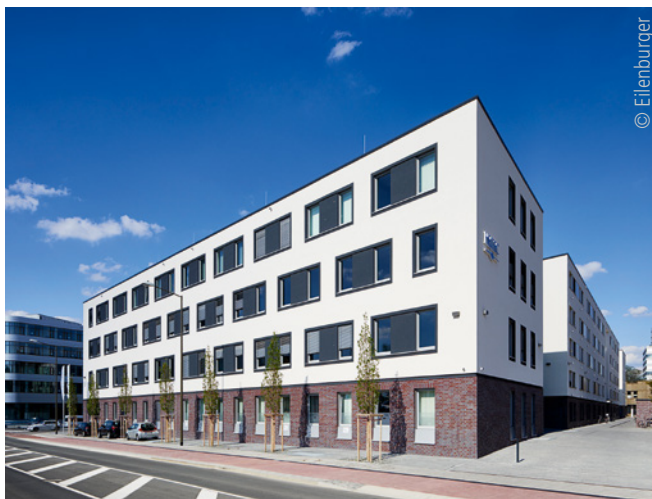
Abb. 7: Bodentiefe Hafencity-Fenster sorgen für guten Schallschutz
